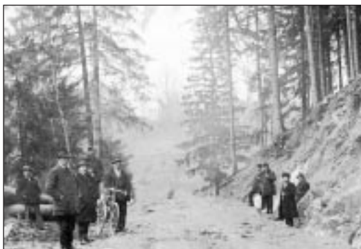
Na vzácném snímku z roku 1906 je zachyceno pracné budování silnice nad Vírem.
