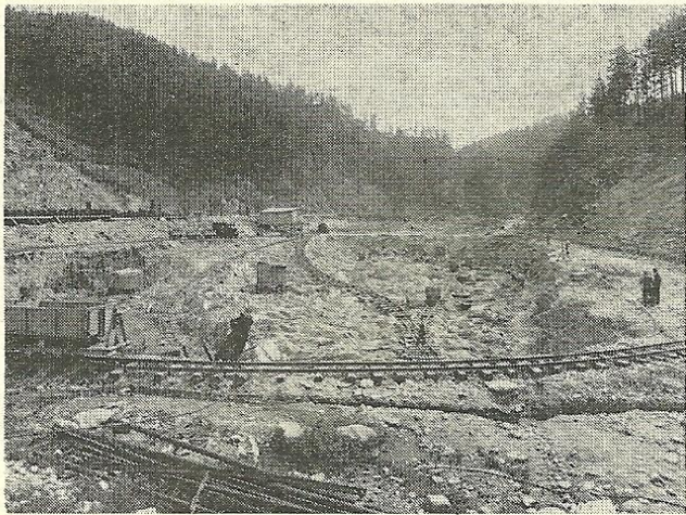
Obr. 3. Výlom základů hráze v pravobřežní jínce (1949). Foto archiv
